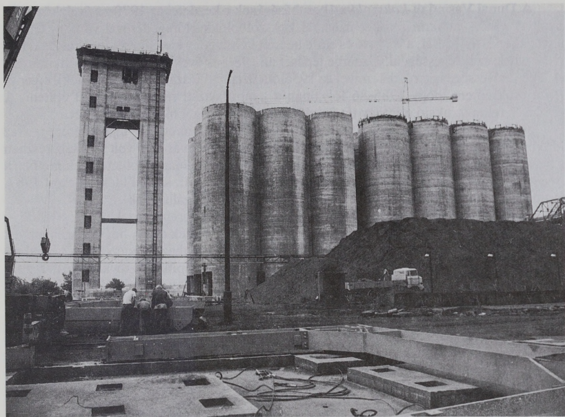
Széntároló betonbunkerek építése, 1984
