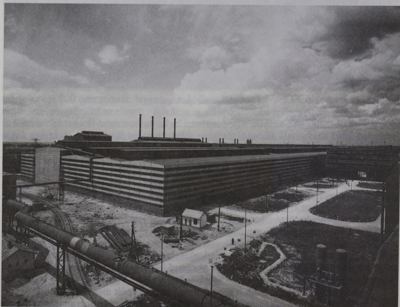
A hideghengermű építés közben, 1963
