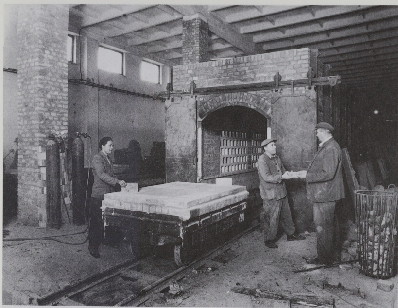
Tűzálló téglák égetése alagút kemencében, 1953
