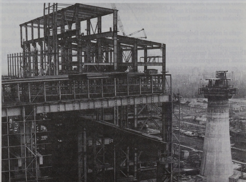
A konverter csarnok és a kémény építése, 1979
