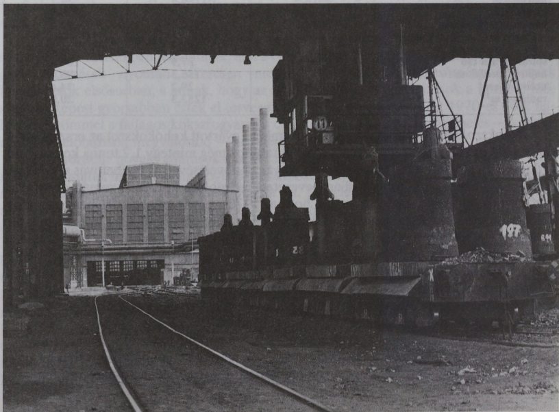
A megszilárdult öntecsekről a kokillák lehúzása, 1973
