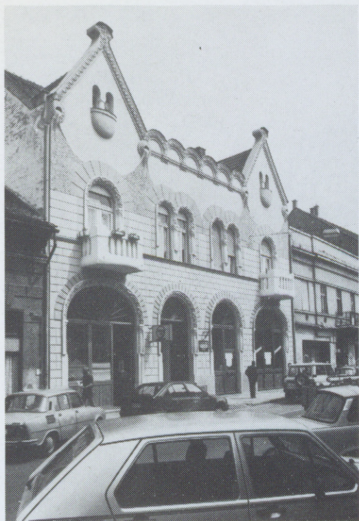
Ady Endre utca újjávarázsolt épülete
