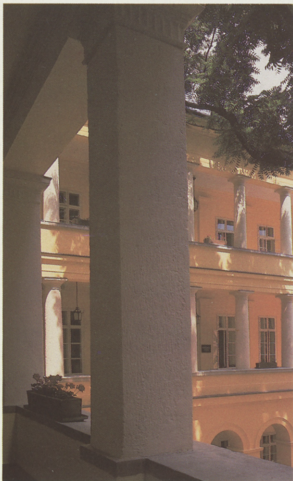
51. A főépület udvari árkádjainak részlete
