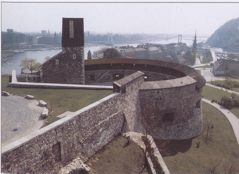
52. Rekonstruktion einer einstigen Torbastei am Süden des Burgberges
