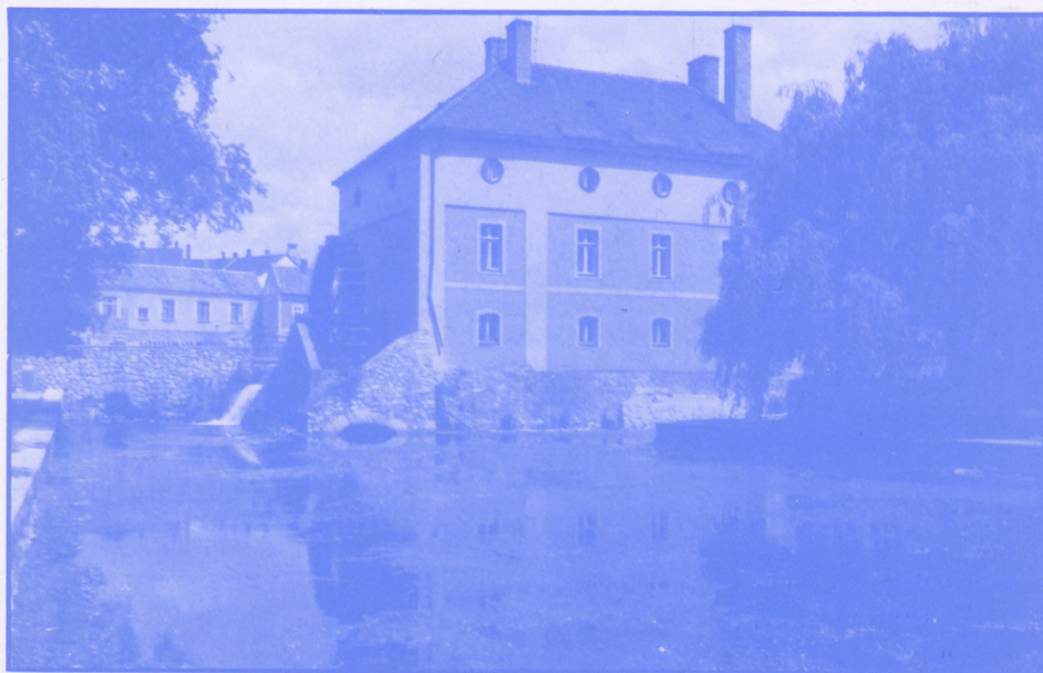
A tapolcai Gabriella szálló felújítása
