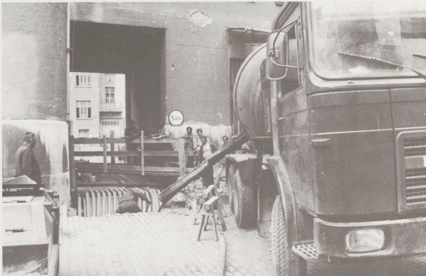
Kábelvonal bővítése. Postaudvar
