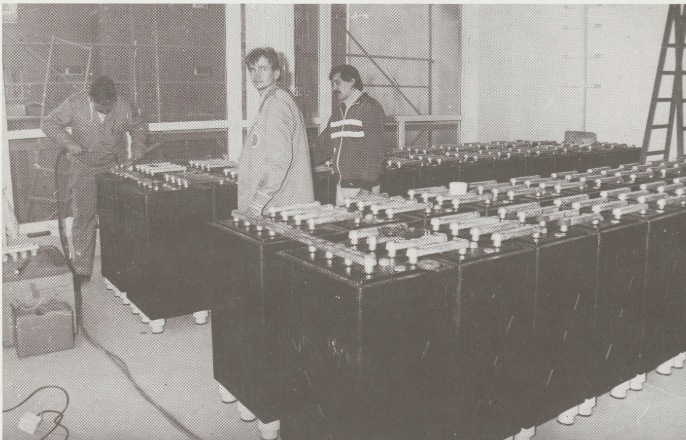
Szerelik a soproni akkumulátorteletet
