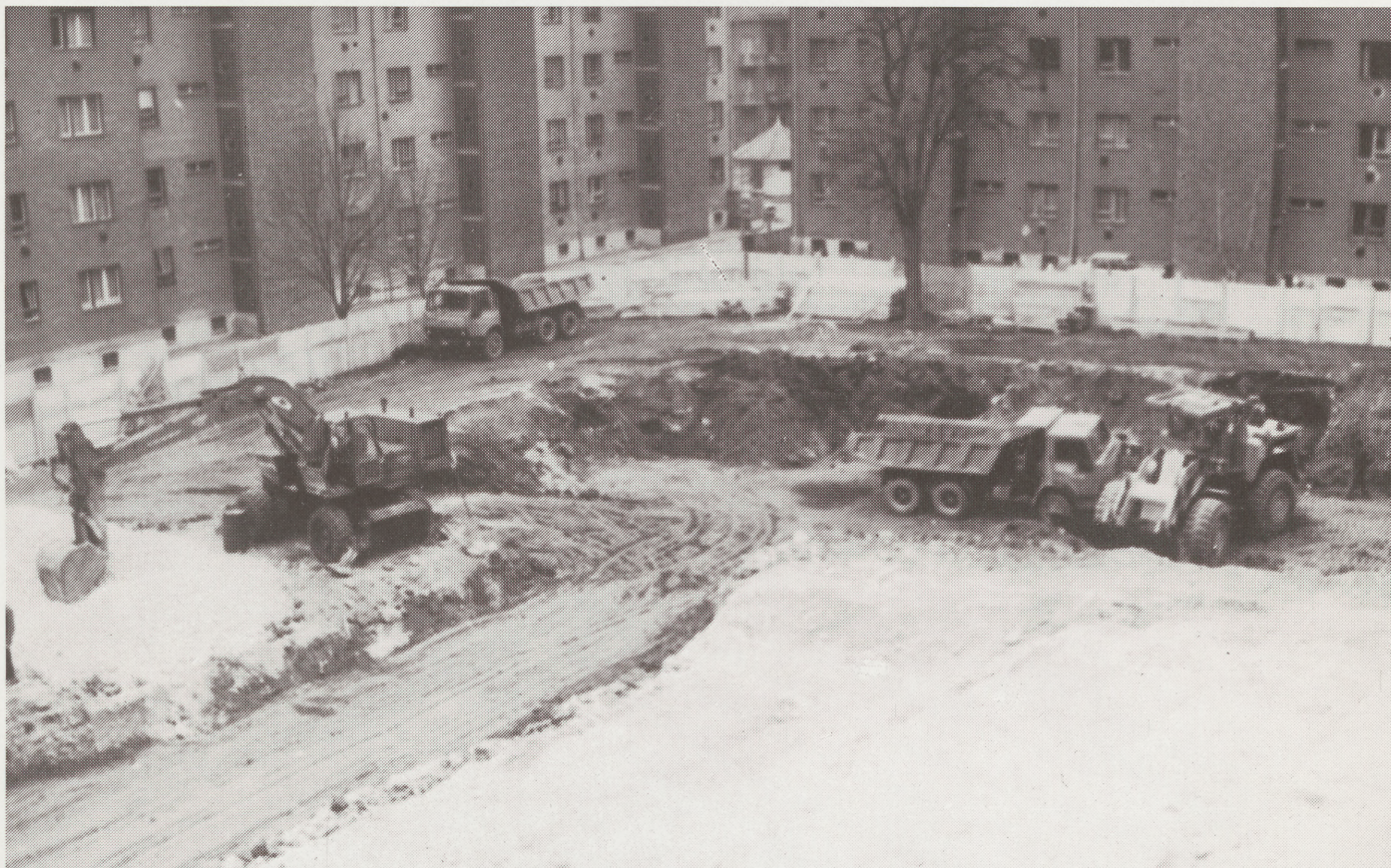
A műszaki épület földmunkái
