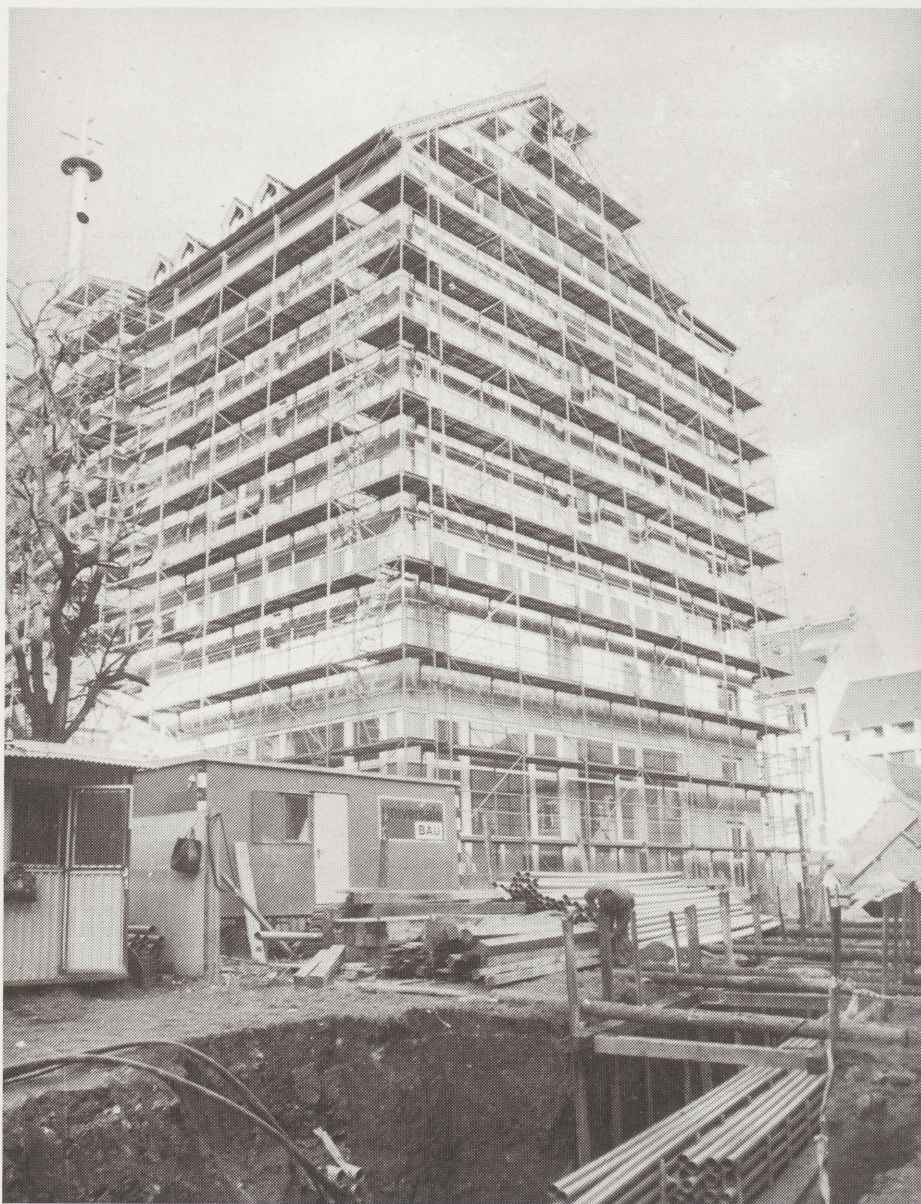
Tető alá került a műszaki épület
